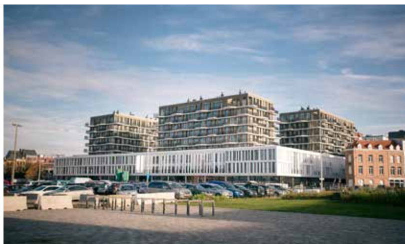
De gevels zijn afgewerkt met een parementbaksteen, de balkonterrassen in prefab zichtbeton.
